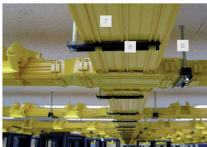
2. Instalace OptiWay na strop
