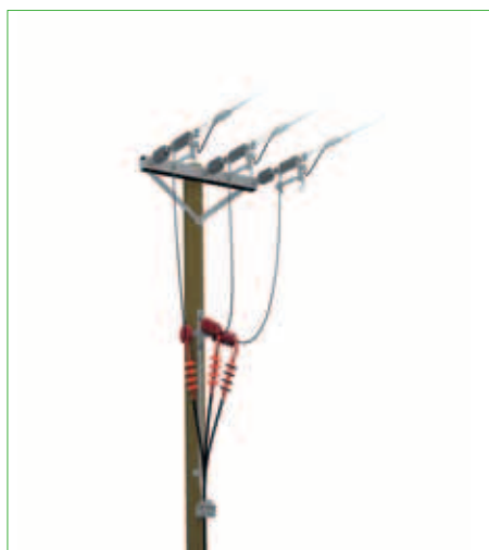
Svod z venkovního vedení do kabelu
