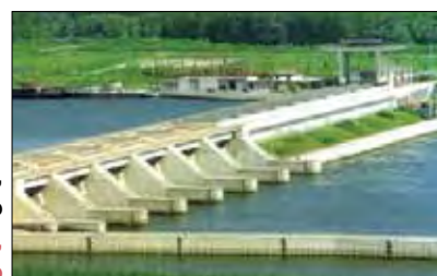
elektrárna, Rakousko elektrárna, Rakúsko
