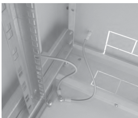
Detail vodivého pospojování
